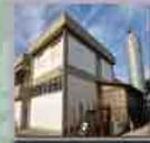
**STRUTTURA A TELAIO IN CEMENTO ARMATO POSTA AL PIANO PRIMO (SUP. MQ 400) COMPOSTO DA APPARTAMENTI, LAVANDERIA, SPOGLIATOIO, MENSA.**
