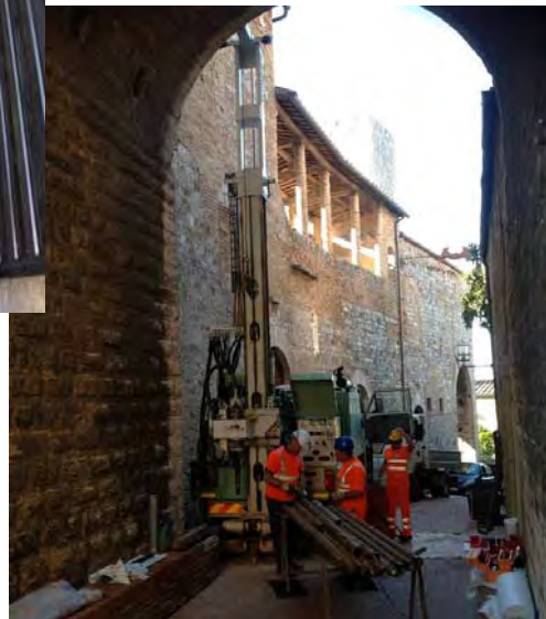
Laboratorio di Geotecnica
