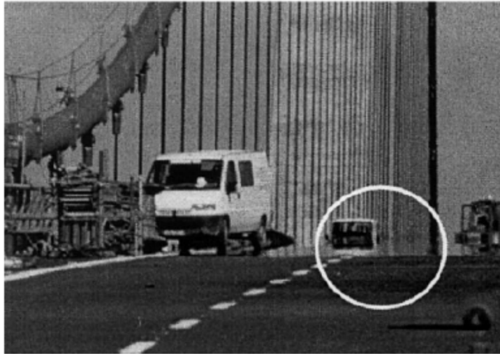
Vibrazioni indotte dal distacco di vortici per il Great Belt East Bridge, Danimarca
